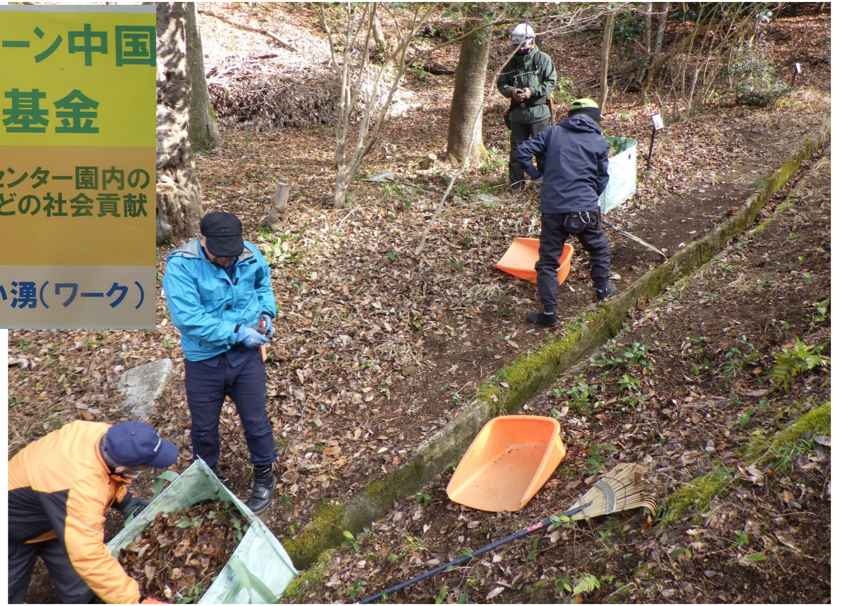
側溝の落葉清掃
